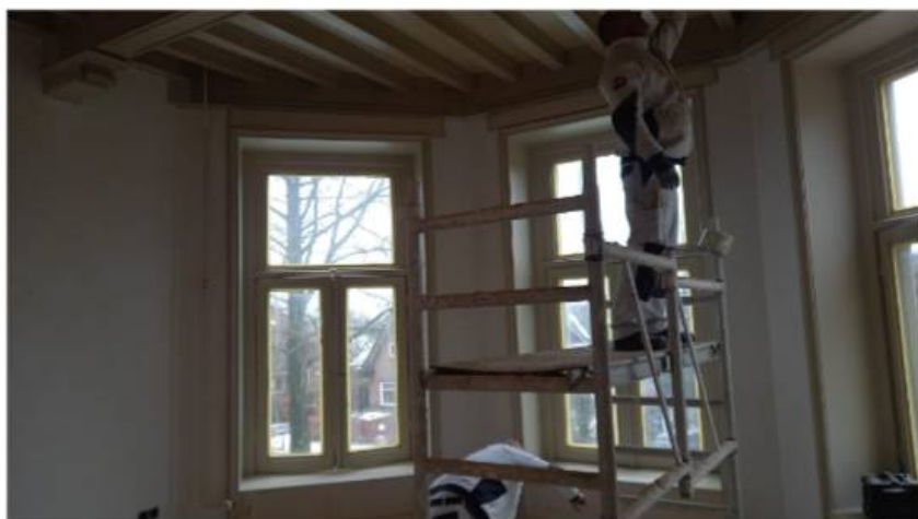
Ook op de eerste etage wordt hard gewerkt.
