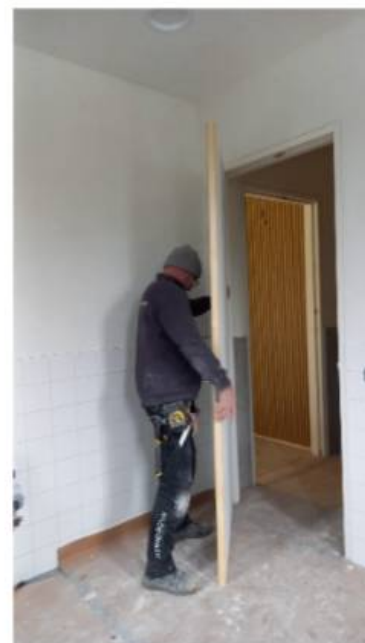
De deur van het nieuwe bloemenhok wordt geplaatst.
