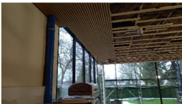
De afwerking van het plafond wordt duidelijk.
