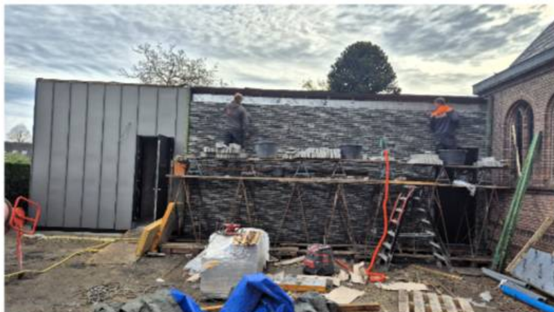
De nieuwe buitenmuur
