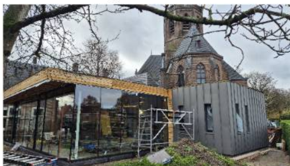
Het glas is geplaatst
